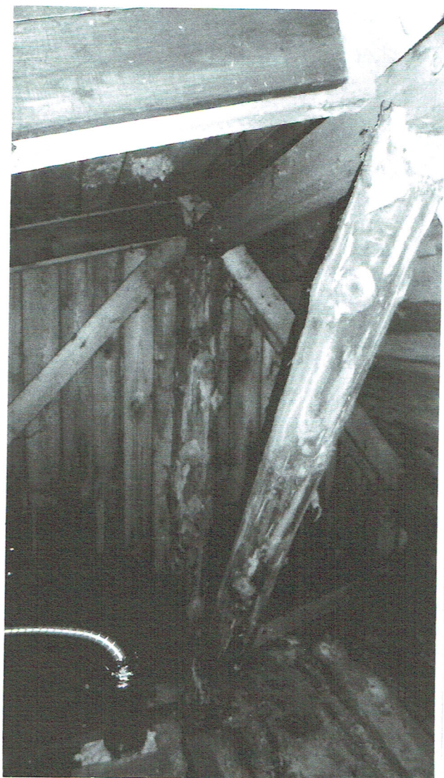
Słup \varnothing 15 cm na ścianie szczytowej z desek. Podparcie płatwi zastrzałem, widoczny zastrzał podpierający krokwie wspornika. Nadbitka krokwi ucięta przed podporą (płatwią).
