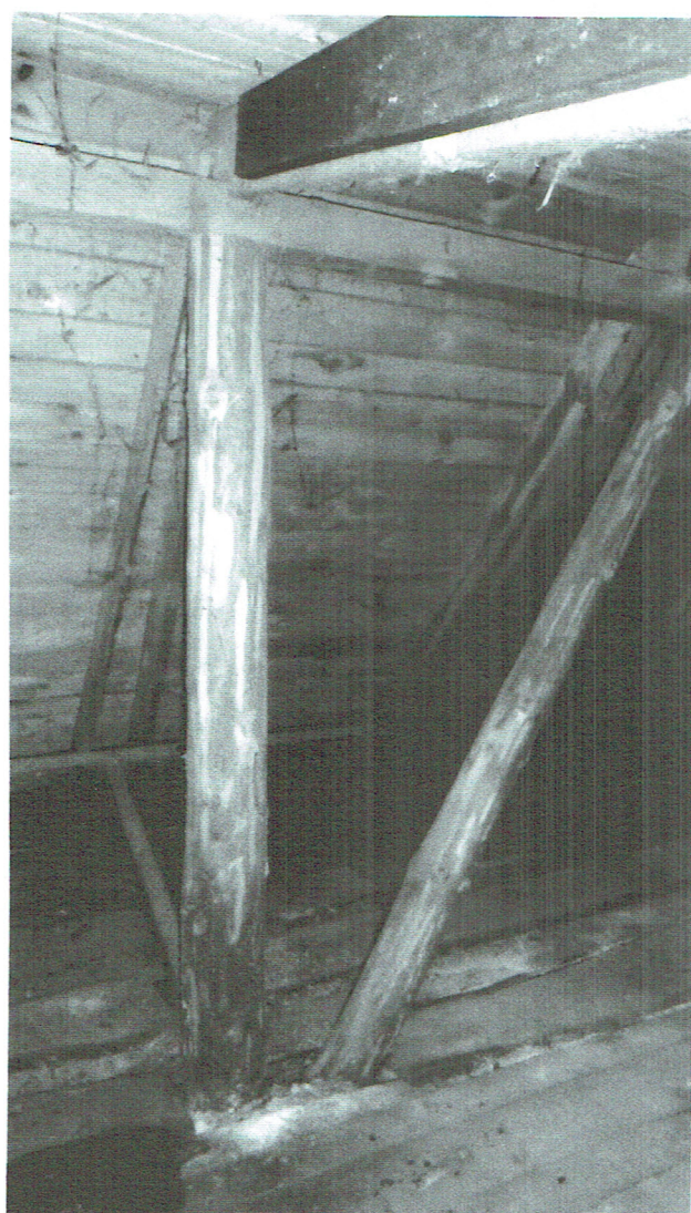
Słup \varnothing 15 na ścianie zewnętrznej pawilonu. Widoczne podwójne krokwie wspornika podparte zastrzałem. Widoczny zastrzał podpierający płatew, nadbitka na krokwi ucięta przed podporą, deskowanie połaci dachowej. Luźno ułożone deski podłogi.
