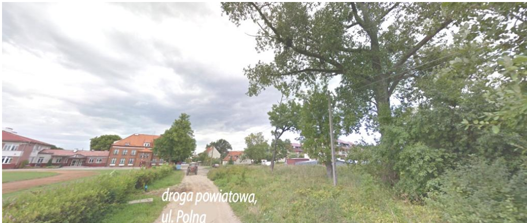
Fot. 2 Widok na drogę powiatową ul. Polna od strony południowej
