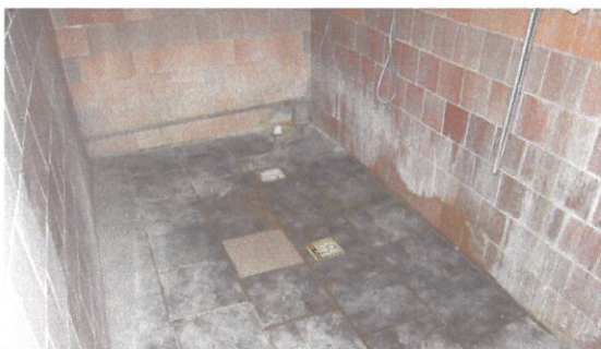
Widok na pomieszczenie z natryskami – okładziny ścian i posadzkę
