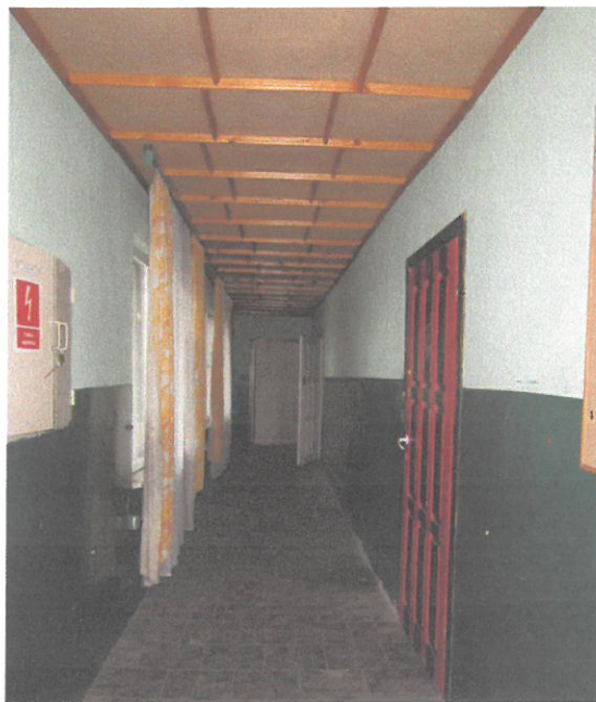
Widok ogólny korytarza głównego.
