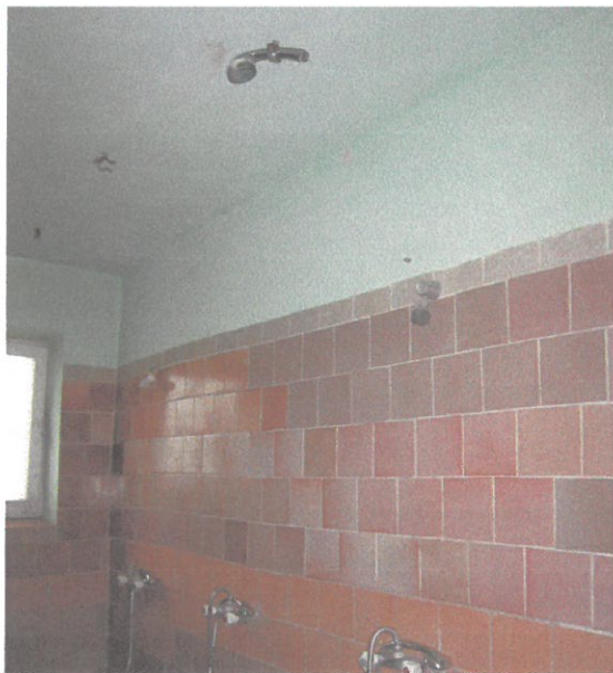
Widok pomieszczenia z natryskami
