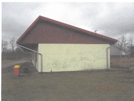
Elewacja szczytu budynku – prawa strona
